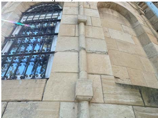
Рис. 4. Внешний вид отдельных трещин и выбоин до 1 мм
