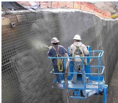
Рисунок 2 - Применение цементация стенок котлована для укрепления откосов котлована
