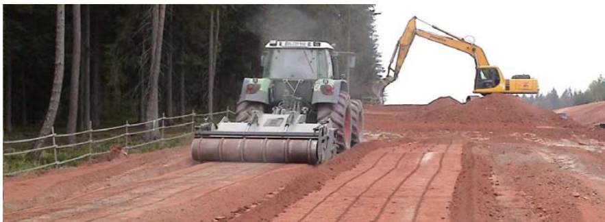
Рис.1 Процесс укрепления грунта
