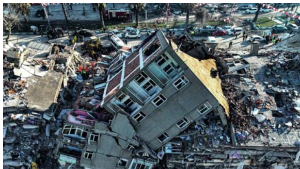
Рис. 1 – Последствия землетрясения в Турции.
