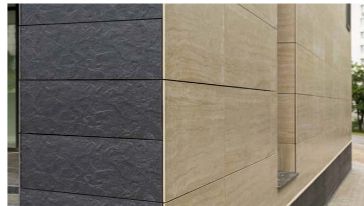
Рис.1 Облицовка фасада керамогранитом
