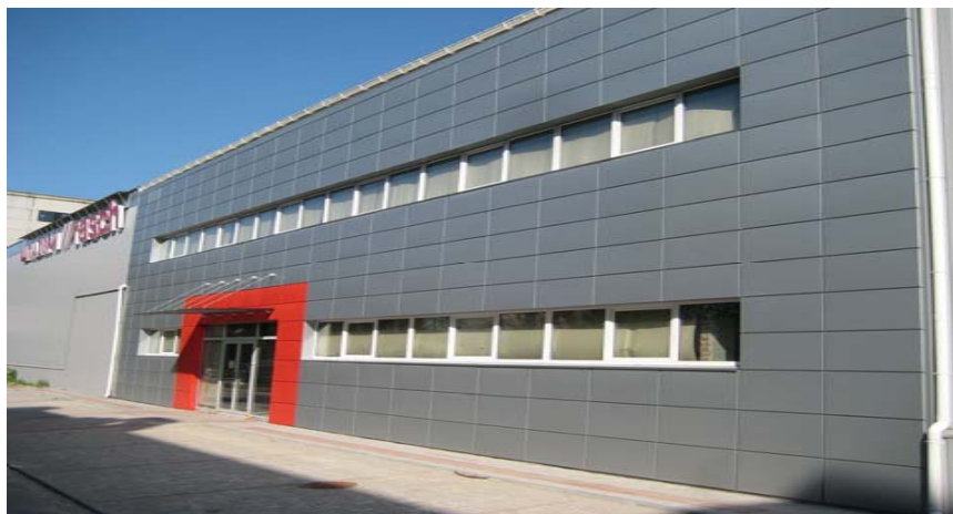
Рис.2 Облицовка фасада кассетами
