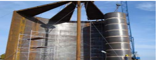
Рисунок 6 — Рулонный метод возведения резервуаров
