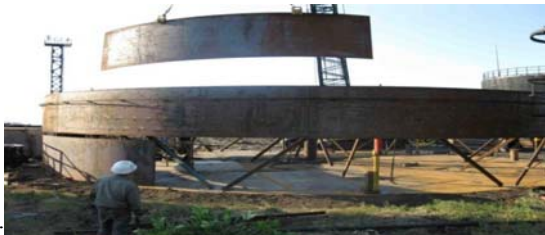
Рисунок 7 – Полистовой метод возведения резервуаров
