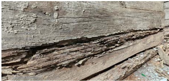
Рис.4. Грибковое поражение древесины в Покровского храма в селе Каменка
