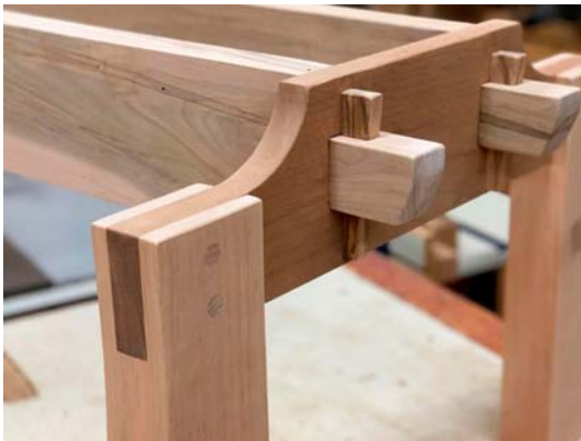
Рис. 1 – Нагельное соединение в деревянных элементах
