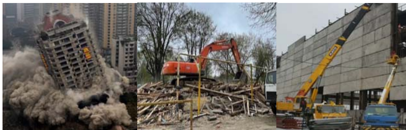
10. Методы демонтажа зданий
