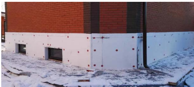
Рисунок 11. Пример утепления здания пенополистеролом
