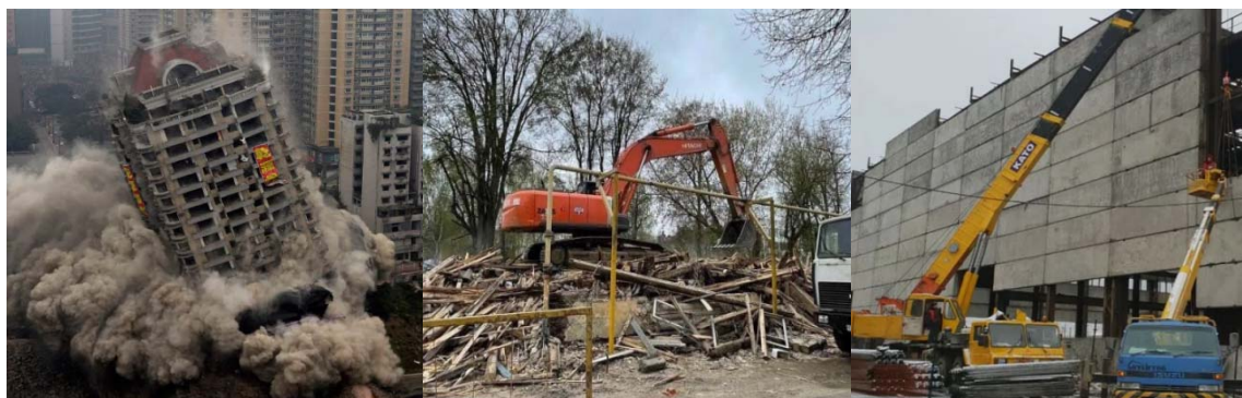
Рисунок 1 - Методы демонтажа зданий
