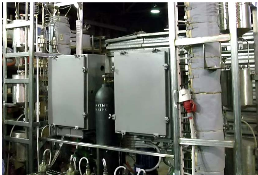
Рисунок 1 – Установка для твердых бытовых отходов
