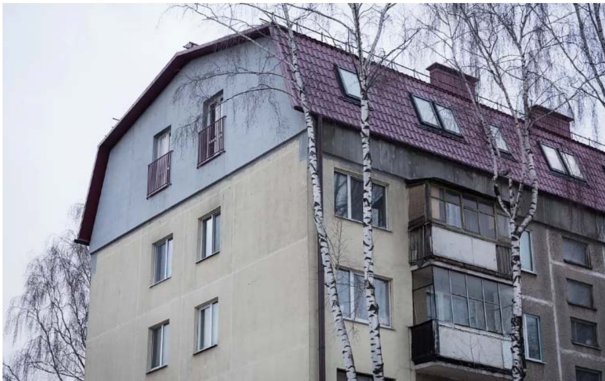
Рисунок 1 – Здание с надстроенной мансардой
