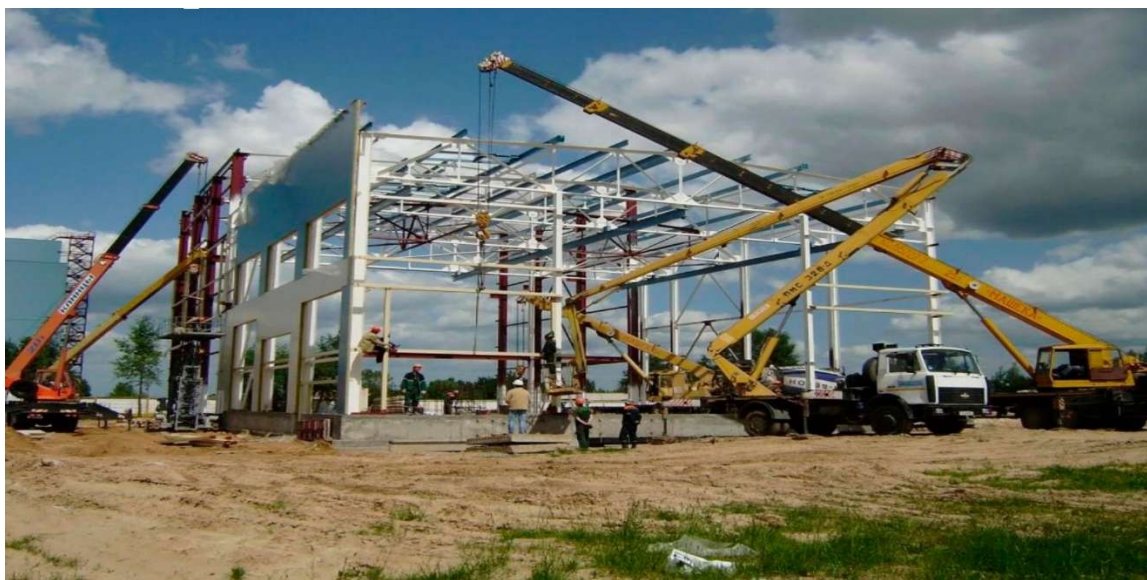
Рисунок 1- Работа комплекта машин на строительном объекте
