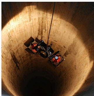
Рисунок 2 – Проверка качества стенок скважины под сваю
