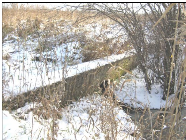
Рисунок 8 - Трубчатый переезд в начале магистрального канала Мк1
