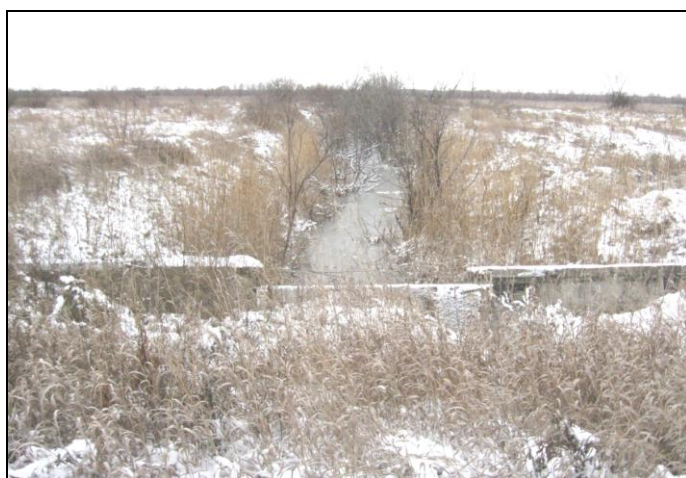
Рисунок 5 - Концевой участок магистрального канала Мк1 у трубчатого переезда
