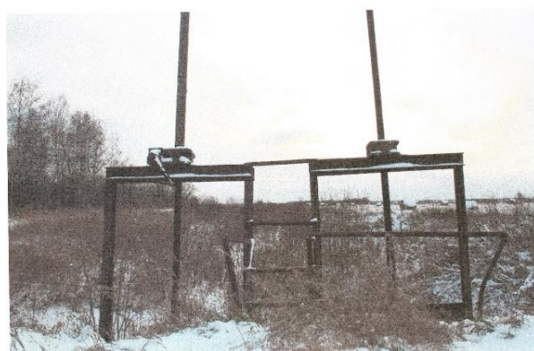
Рисунок 4 – Разрушенный переезд-регулятор
