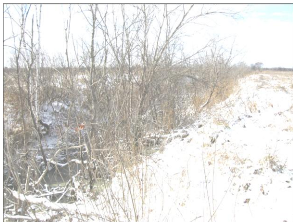
Рисунок 4 - Заросший кустарником полевой осушитель. Глубина воды в канале 0,35 м
