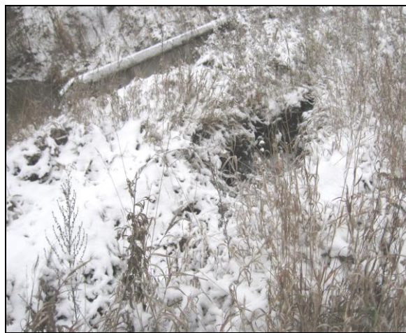
Рисунок 9 - Трубчатый переезд в концевой части обводного канала
