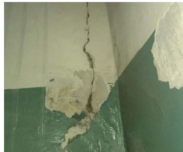
Рис. 1. Воздействие карста на здание Центра социальной защиты населения в г. Уфе.
