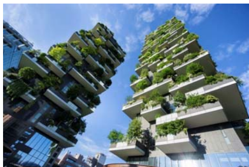
Рисунок 3 – Применение технологий «зеленого» строительства
