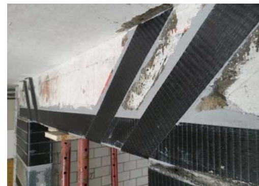
Рисунок 1 – Усиление железобетонных ригелей реконструируемого здания углепластиковыми ламелями
