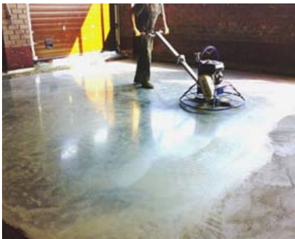
Рисунок 2 – Процесс железнения бетонных поверхностей
