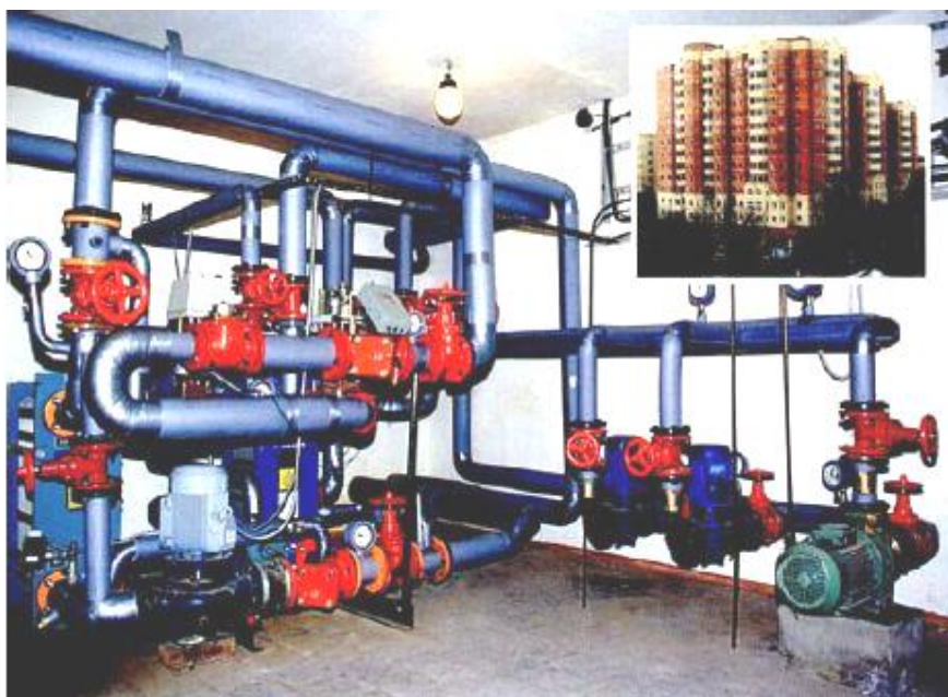
Рисунок 1 – Устройство тепловой станции жилого дома
