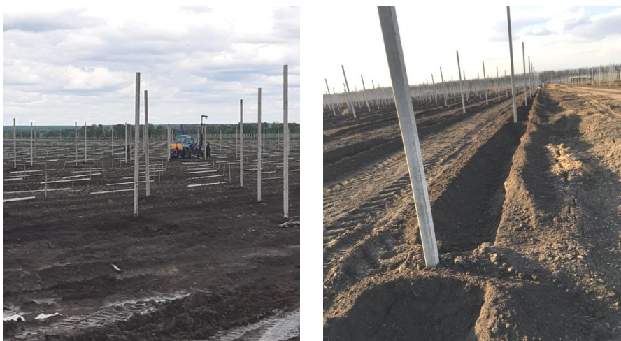
Рисунок 1 – Проведение подготовительных работ перед закладкой яблоневого сада, ООО «Зоринский сад», 2021 г.
