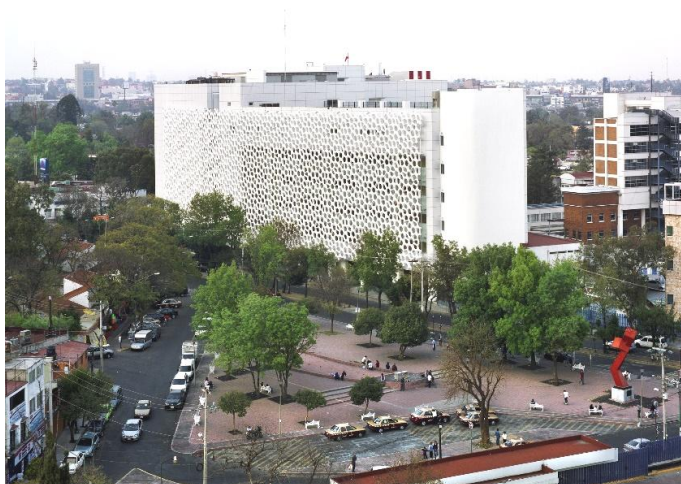
Рисунок 3 – Применение модулей Prosolve370e на госпитале
