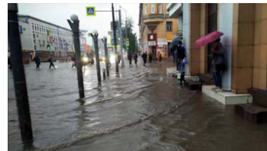
Рис.3 Состояние дорожного полотна г. Иркутск, ул. Дзержинского
