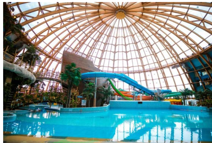
Рис.1 Конструкция из клееного бруса в аквапарке «Питерленд» в Санкт-Петербурге
