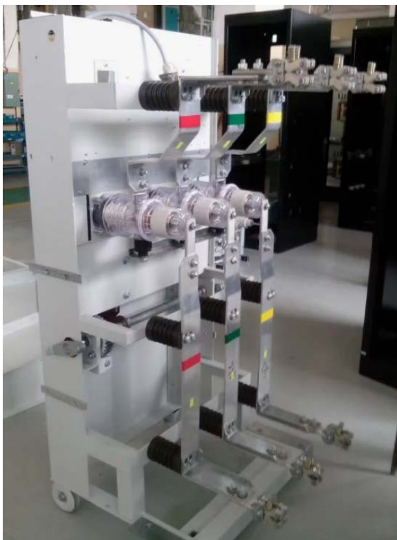
Рисунок 1– Выдвижной элемент (тележка) КРУ К-104
