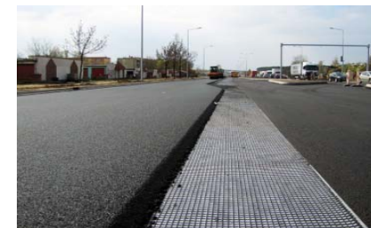
Рисунок 2 – Применение геосинтетической сетки для армирования асфальтобетона
